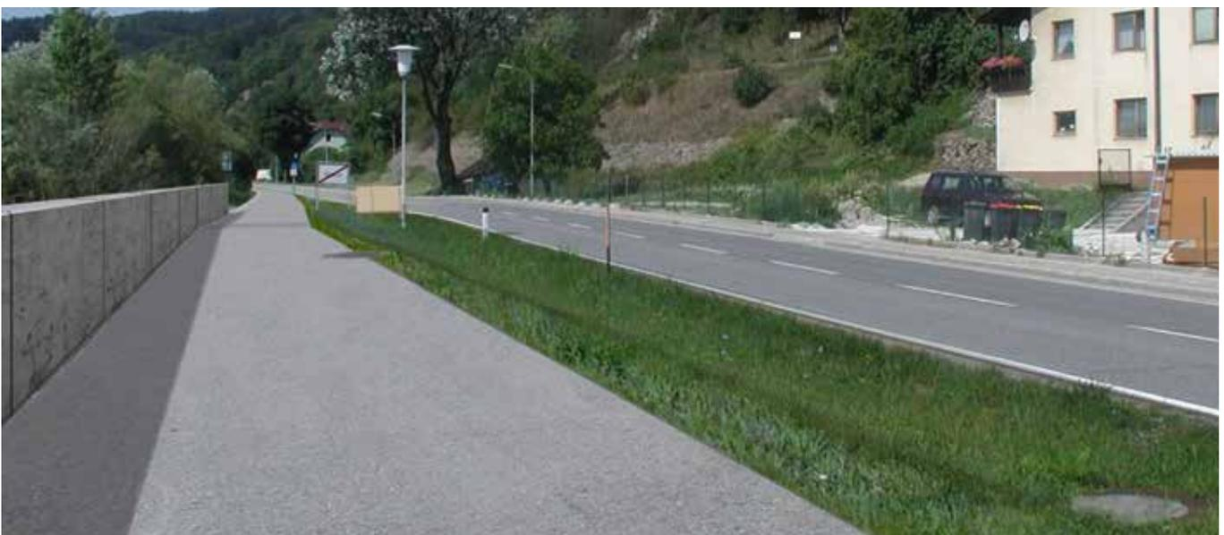
Die Fotomontage zeigt recht gut die geplanten Baumaßnahmen, die sich durch die Erhöhung des Treppelweges und die Erreichung der Schutzmauer ergeben.
